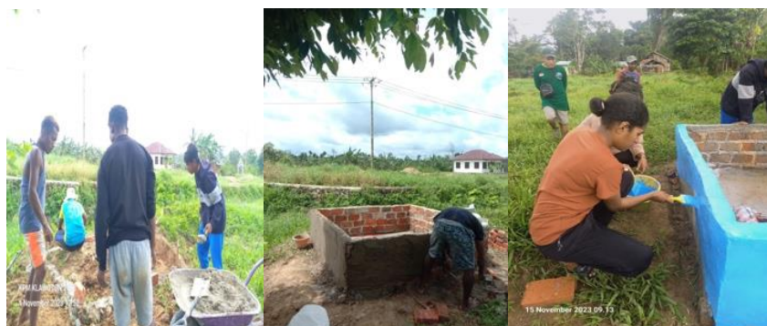
Gambar 5. Pembuatan bak sampah permanen di Kampung Klawoton
