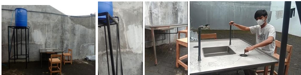
Gambar 9. Instalasi dan Uji Coba Sistem Tandon Air oleh Mitra
